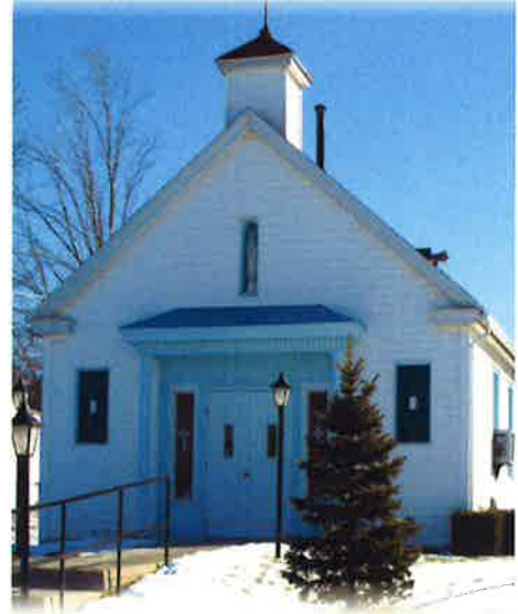
Elba Site 65 S. Main St., Elba
